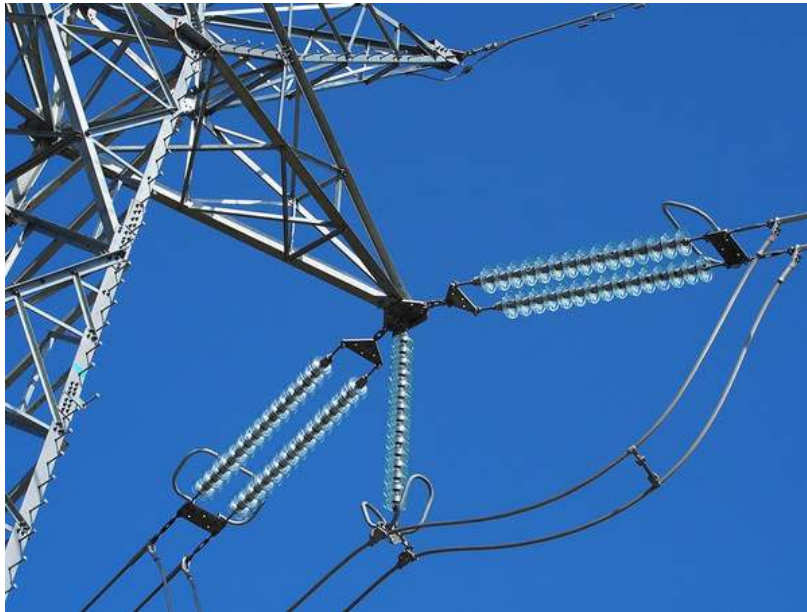
نمونه‌هایی از زنجیر مقره کششی و جامپر
