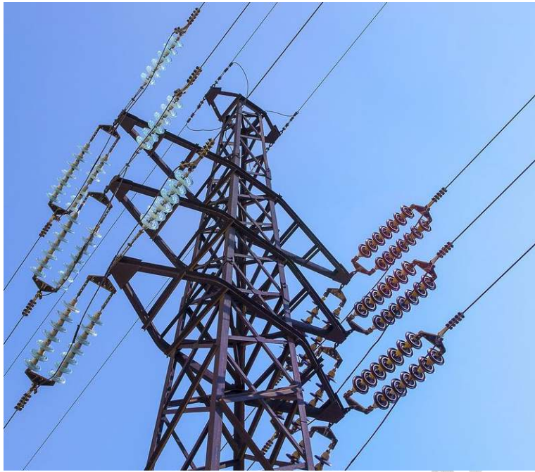
زنجیره مفره کششی چندتایی (با دو زنجیر موازی برای افزایش استحکام مکانیکی)
