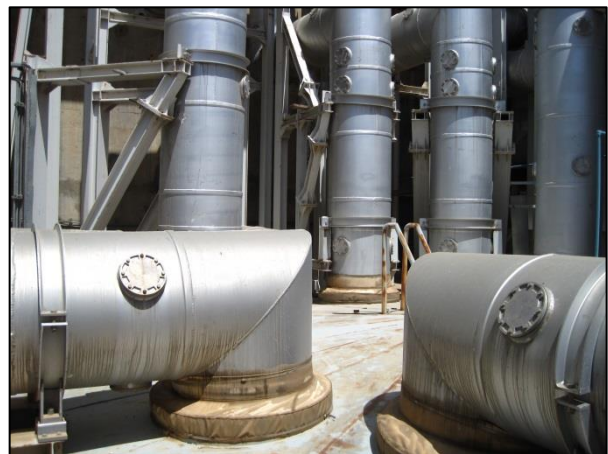
شکل ۳-۸-۱۵- باس داکت‌های بین ژنراتورها و ترانسفورماتورها
