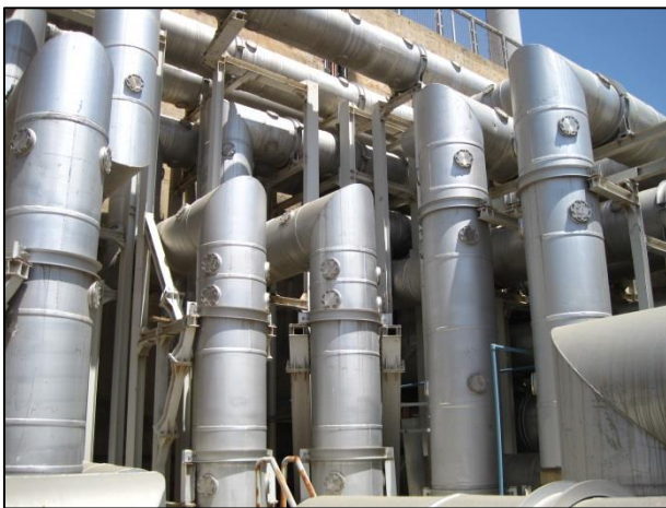
شکل ۳-۸-۱۵- باس داکت‌های بین ژنراتورها و ترانسفورماتورها
