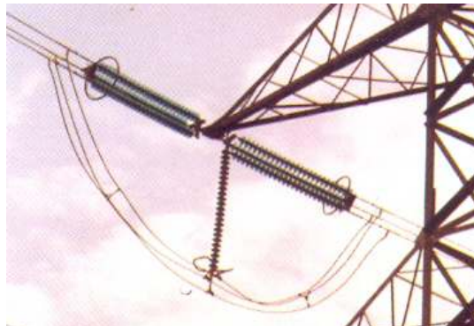
شکل (۶-۱۴). نمونه‌ای از زنجیره مقره جامپر
