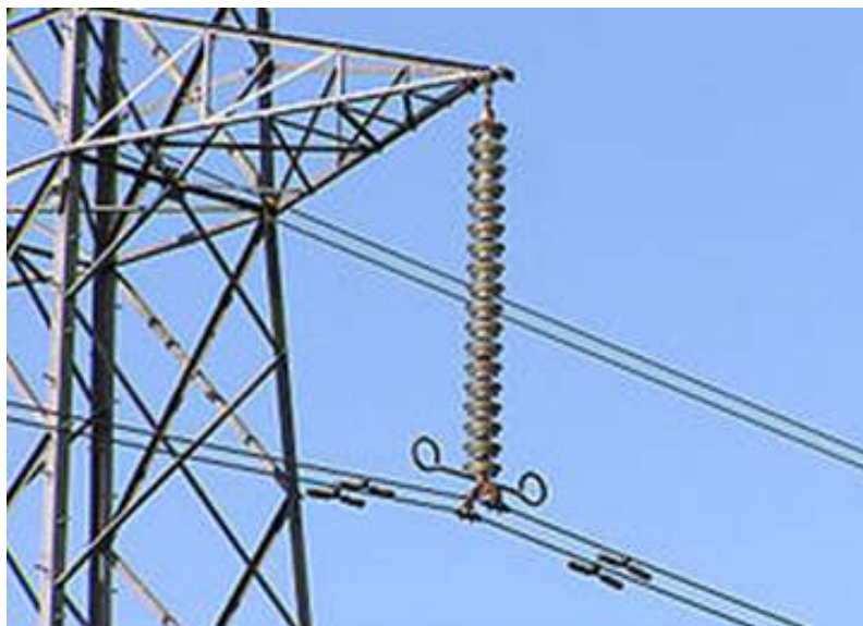
شکل (۶-۹). نمونه‌ای از زنجیره مقره آویزی (غیر کششی I شکل)
