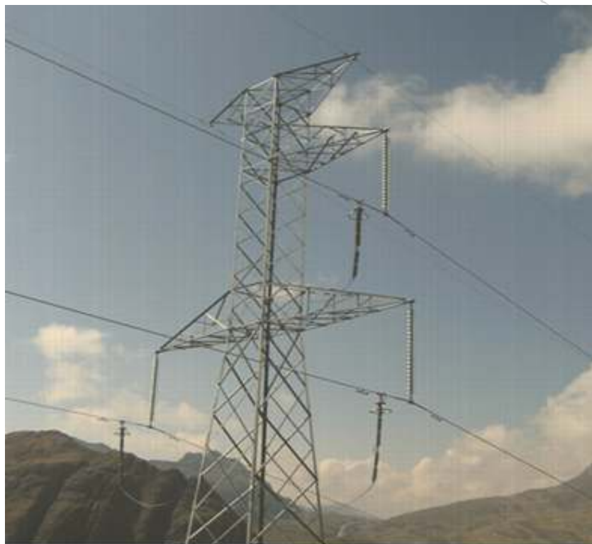
شکل (۶-۲۰). برقگیر خطوط انتقال نیرو
