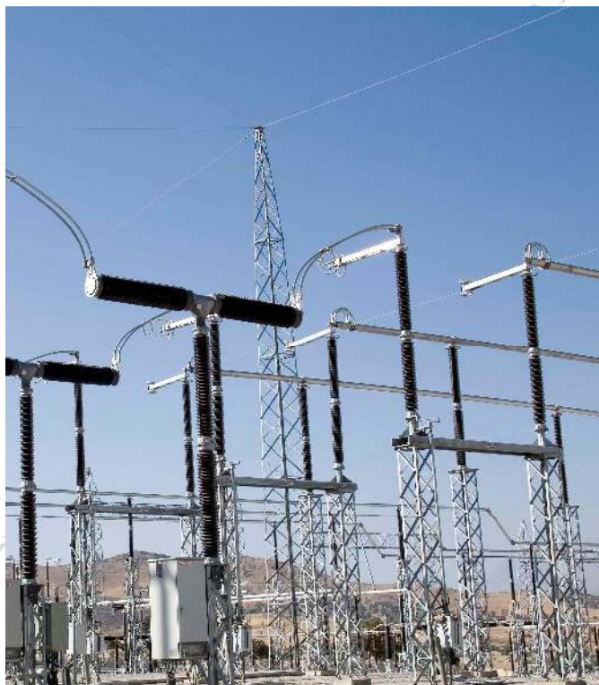
شکل (۳-۷). حفاظت پست در برابر اصابت مستقیم صاعقه با استفاده از سیم محافظ
