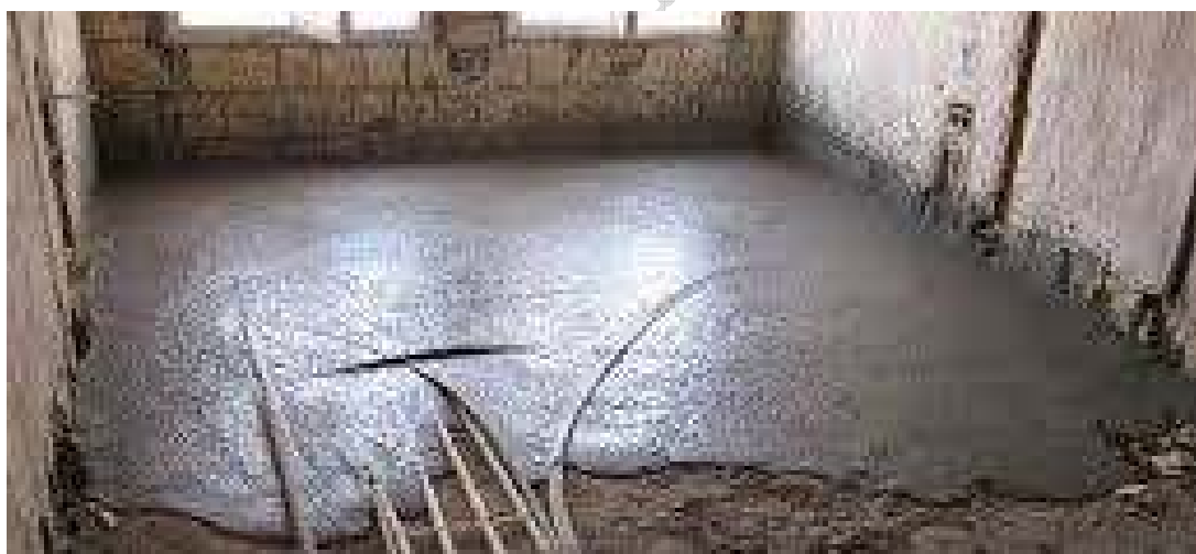
نمونه‌ای از سیم کشی توکار (از کف و دیوار)
