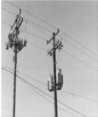
تصویر ۷-۴: بانک خازن روی تیر با فیلتر هارمونیک
