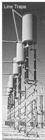
تصویر ۱۳-۲۰: خازن کوپلینگ (چپ) و لاین‌تراپ (راست)
